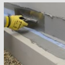
Bed MC-FastTape in en breng de laatste afdichtingslaag aan
