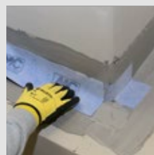
Breng MC-FastTape ca. 10 cm overlappend met het afdichtingsmateriaal aan op de binnen- of buitenhoek.
